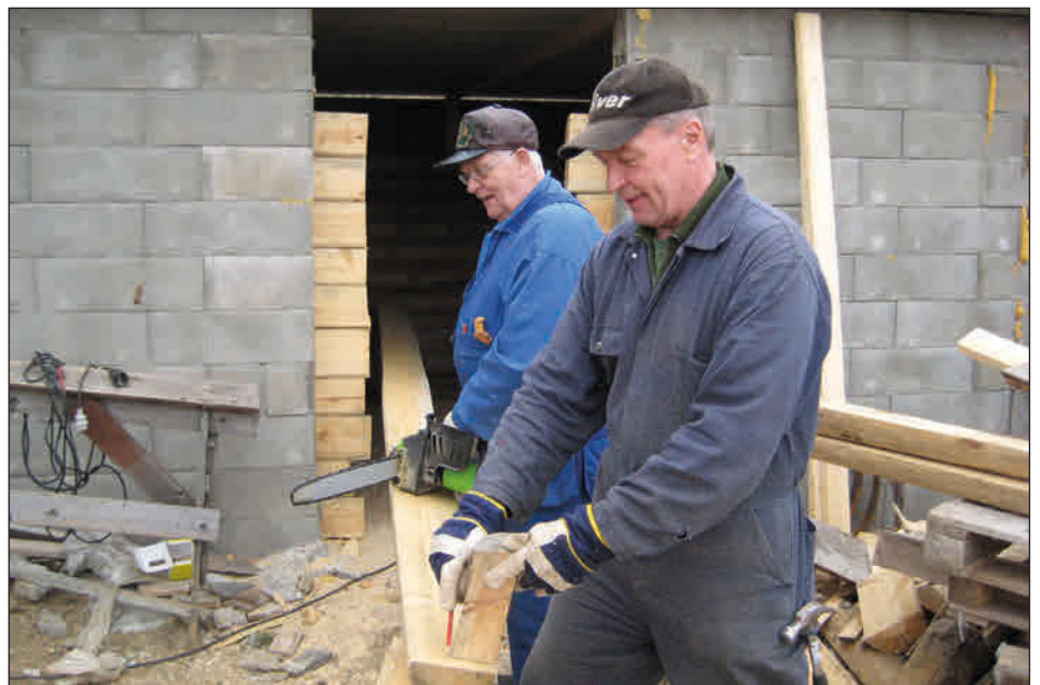
Korsua rakentamassa Rainer Syrjäjä ja Ilmari Kivistö.
